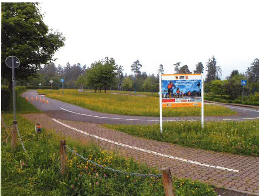
Bild 1: Blick auf das in den Gehwegbereichen verlegte Pflastersystem des Verkehrsübungsplatzes
