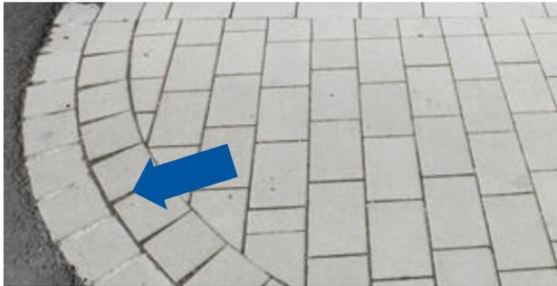
Bild 58: Durch das Verziehen der Pflastersteine entstehen Keilfugen, deren Breite zu begrenzen ist
