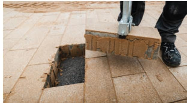
Bild 66: Vollständige Fugenfüllung nach maschinellem Einschlämmen
