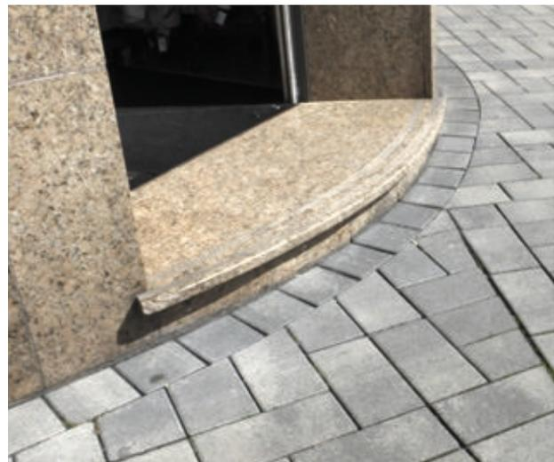
Bild 62: Positivbeispiel – Vorbildlich ausgeführter Anschlüsse an Schräge und Rundung im Bereich eines Hauseingangs
