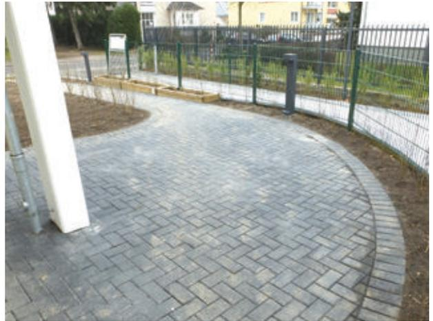
Bild 67: Pflasterdecke, bei welcher die Bauabschlussreinigung offenbar versäumt wurde. Dies kann zu hartnäckigen Verschmutzungen, zum Beispiel durch das Fugenmaterial, führen
