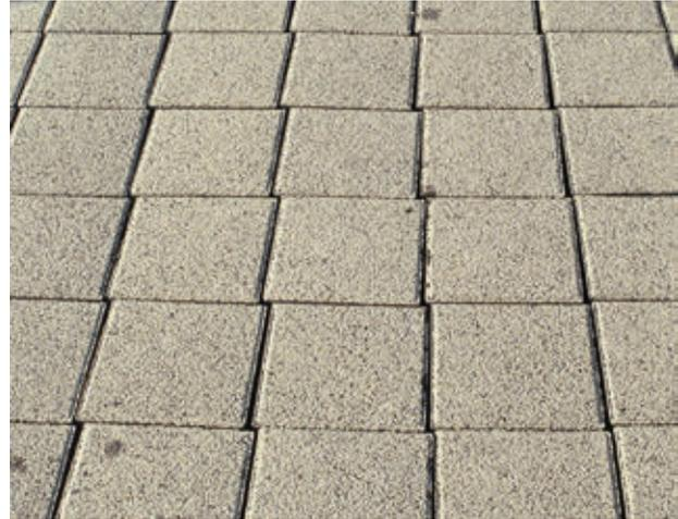
Bild 38: Schadhafte Pflasterfläche durch Abwandern des Fugenmaterials aufgrund fehlender Filterstabilität zwischen Fugen- und Bettungsmaterial
