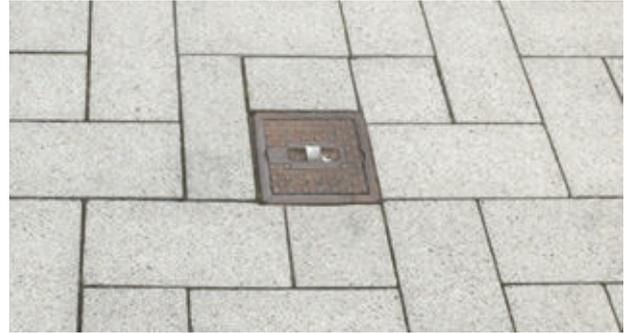
Bild 52: Passgenauer Anschluss an eine quadratische Straßenkappe durch geraden Zuschnitt im Nassschnittverfahren
