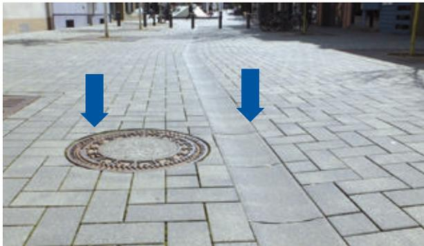
Bild 47: Die Oberfläche der Pflasterdecke muss an Entwässerungsrinnen und Einbauten überstehen
