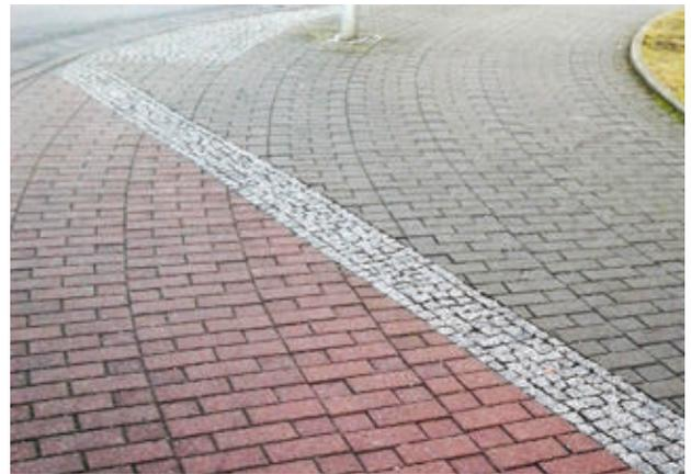
Bild 60: Odenwälder Verband aus Rechtecksteinen bei einem kurvenförmig verlaufenden Gehweg (Foto: Wellner)
