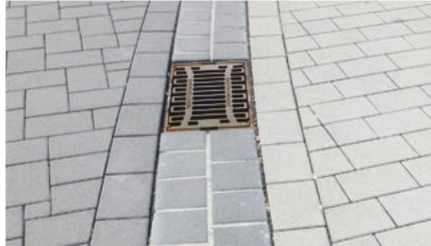
Bild 61: Positivbeispiel – Vorbildlich ausgeführte Anschlüsse bei einem beidseitigen Anschluss an eine Muldenrinne
