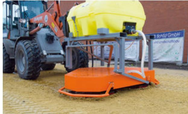
Bild 65: Maschinelles Einschlämmen der Pflasterdecke mit Hilfe der am Radlader montierten Einschlämmeinheit
