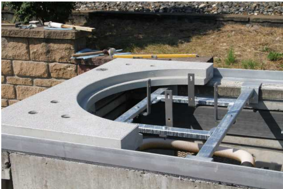
Abb.: ARPANA-Einfassungsrahmen mit eingelegter Baumscheibe und Unterflurverankerung für Baumschutzkorb
