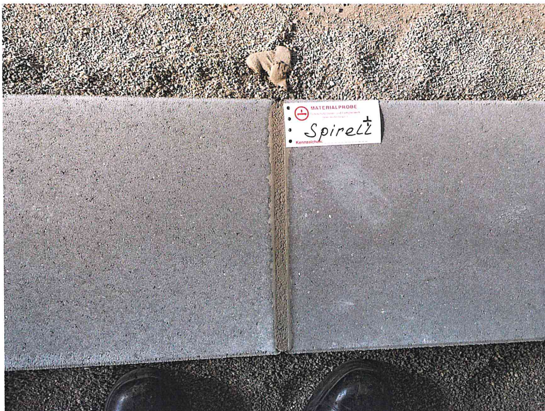
Bild 1. Die zu prüfende Pflasteroberfläche SPIRELL im aufgebauten Zustand.
